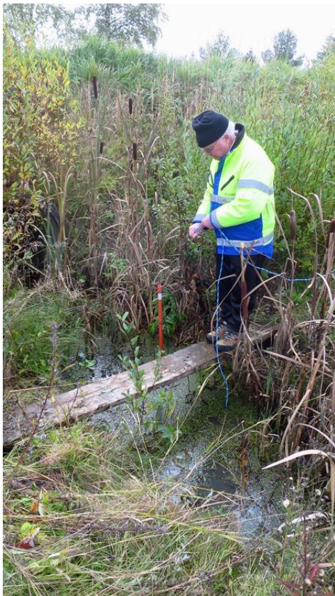
Kuva 3.13 Loukkaanojassa oli runsaasti kasvillisuutta, kun jatkuvatoimiset mittalaitteet asennettiin ojiin 24.9.2019. Martti Seppälä sitoo naruja merkiksi mittarien asennuspaikkaan. Kuva: Maria Kämäri.
